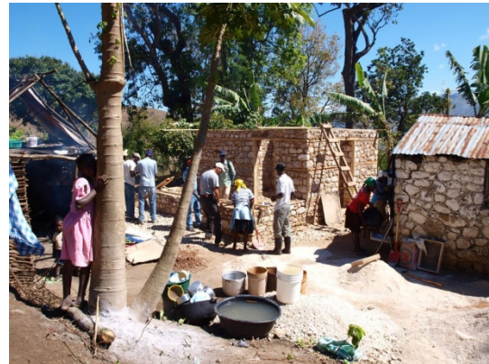
Eine Solidargruppe beim Bau
